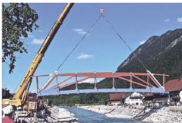
Einheben der beiden Brückentragwerke © Maurer Söhne GmbH & Co. KG
